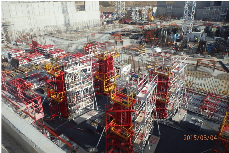
トカマク複合建屋の工事(2015年3月)
