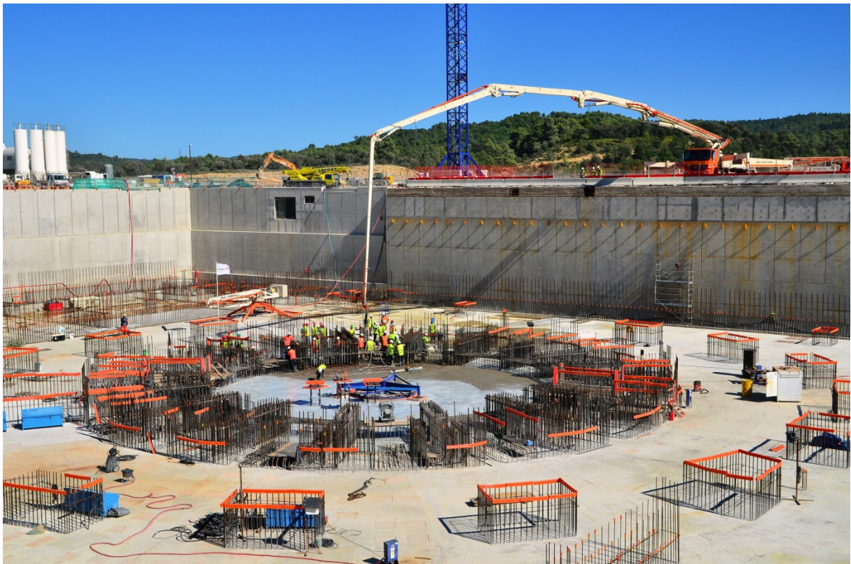
ITER サイトでのトカマク本体建屋地下 2 階のコンクリート打設の様子(提供:ITER 機構)
