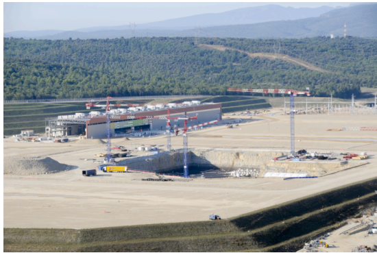
図1 建設工事が進むトカマク複合建屋ピット（手前）とポロイダル磁場コイル巻線建屋（左奥）（2011年9月、ITER機構提供）
