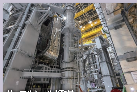
サーマルシールド取付
