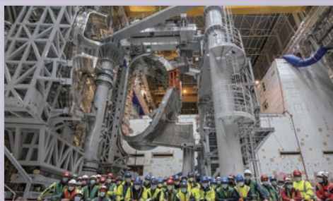
真空容器セクターを組立ツールへ
