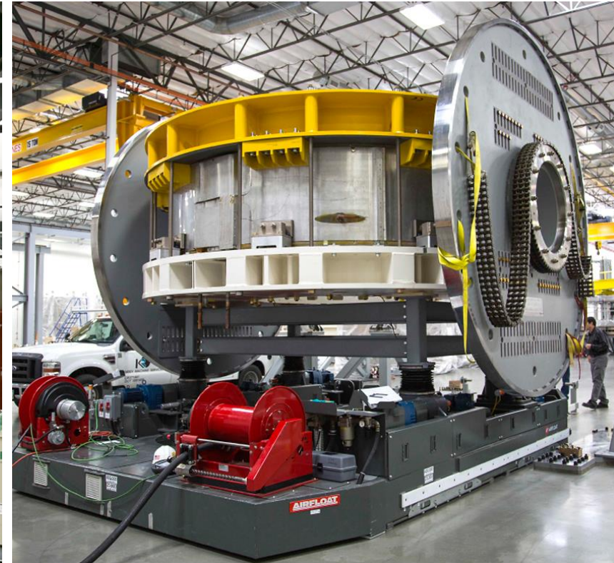
調整運転を完了したモジュール倒立装置
