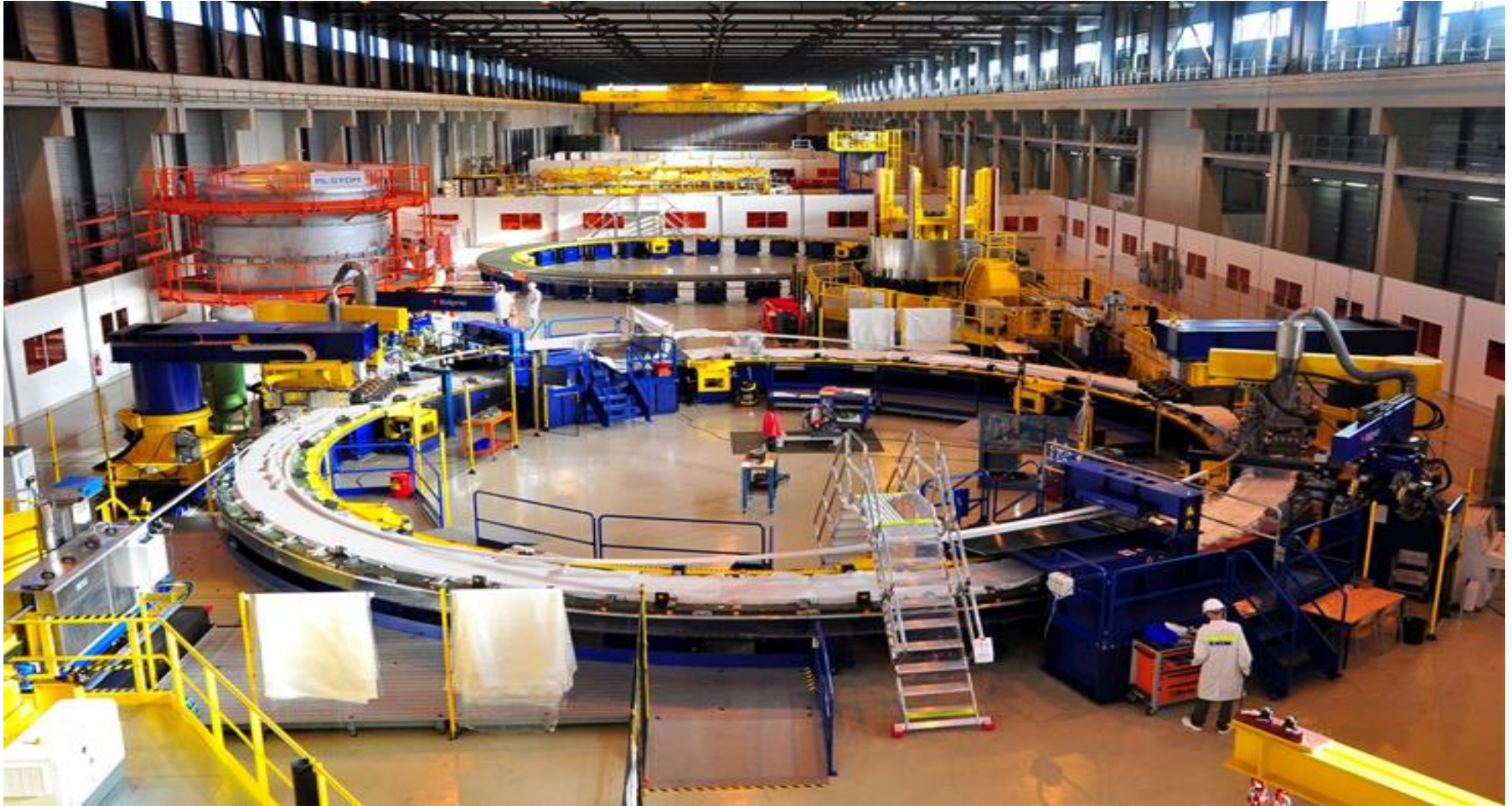
ITERサイト内のPFコイル巻線建屋にてF4EのPFコイル巻線作業が進捗中
