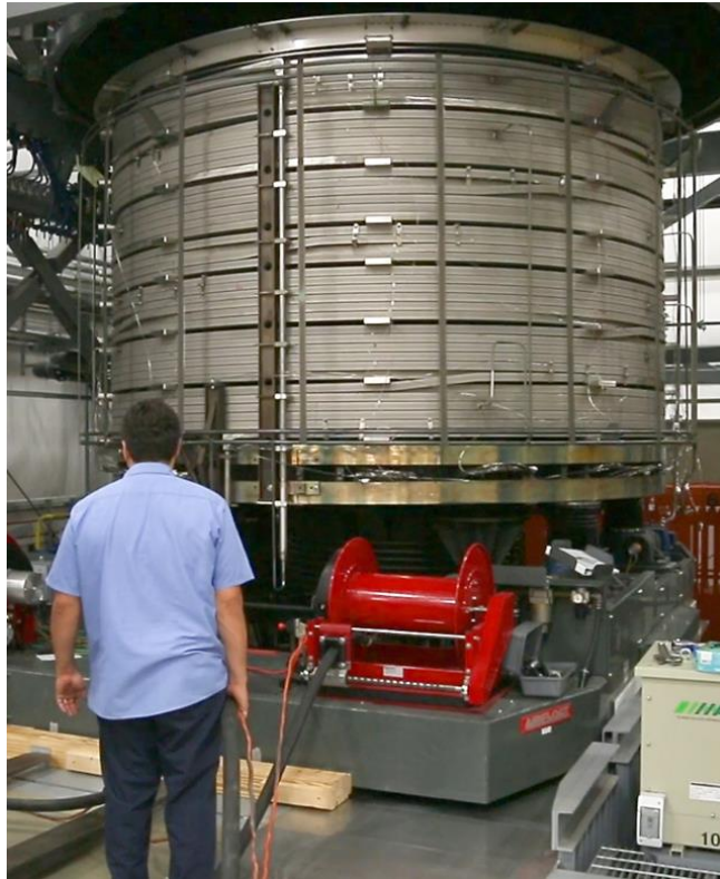
#1モジュール巻線熱処理
