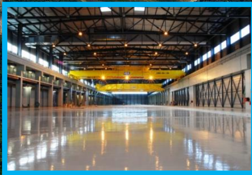
PF組立建家 幅45m、長252m、高17m (2012年2月完成)
