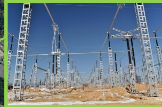
高電圧受変電設備エリア 鉄塔、電線の敷設作業中
