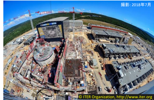
ITERの建設が行われている、南フランスのサン・ポール・レ・デュランスにあるITERサイト(広さ180ヘクタール)
