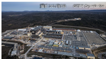
ITERの建設が行われている、南フランスのサンポール・レ・デュランスにあるITERサイト(広さ180ヘクタール)
