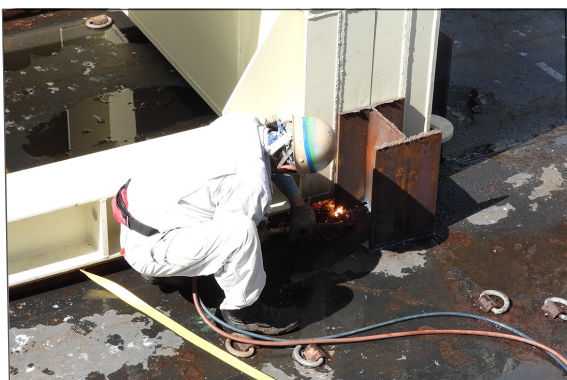
図6 H鋼の溶断作業の様子
