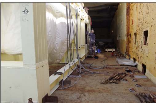
図9 TFコイルの架台にワイヤーを取り付ける
