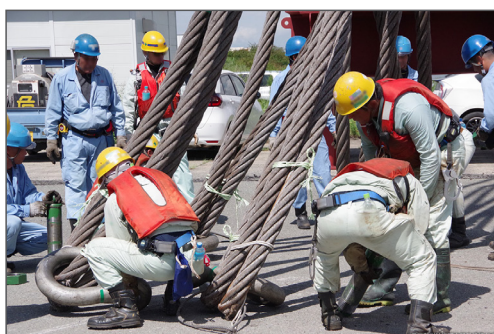
図3 作業員がワイヤーにシャックルを取り付けていきます。
