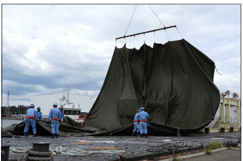
図8 TFコイルに保護シートを掛けていきます
