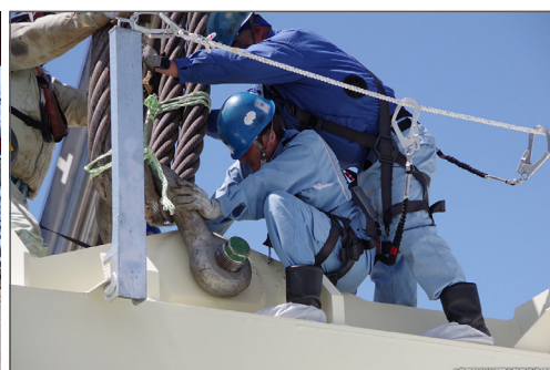
図4 シャックルをTFコイルの架台に取り付けます
