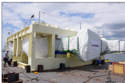
図6 TFコイルの架台を台船に溶接していきます
