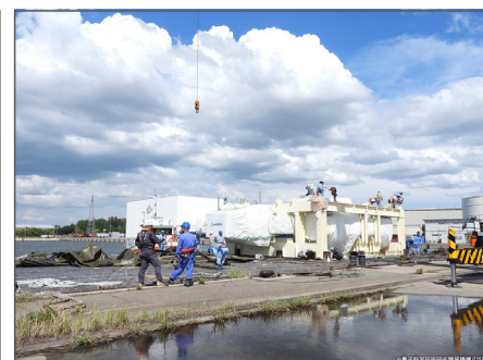
図7 TFコイルにシートを掛けていきます
