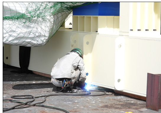
図5 台船に積み込んだTFコイルは、作業員によって複数個所の溶接が行われます
