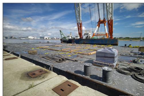
図2 TFコイルを配置する台船上に木材が敷かれ、積み込みの準備が整いました
